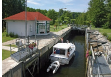
Schleuse Hermsdorfer Mühle
